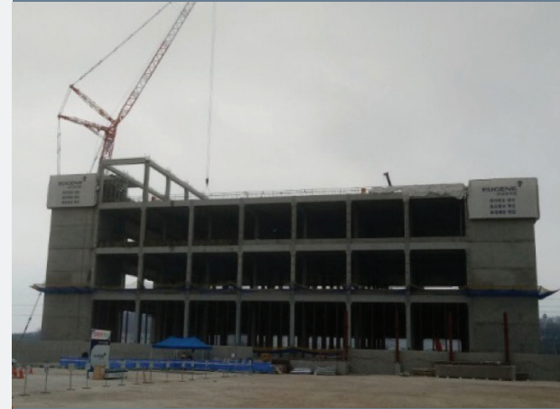
물류창고 시공 사진
